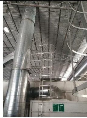
二级滤芯除尘器+排气筒 (FQ-03)
