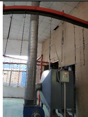
二级活性炭吸附装置+排气筒 (FQ-05)
