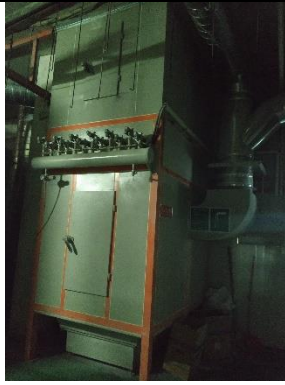
二级滤芯除尘器+排气筒 (FQ-02)
