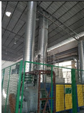
水喷淋+二级活性炭吸附装置+排气筒 (FQ-04)
