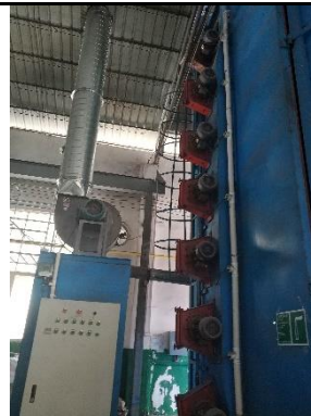
二级滤芯除尘器+排气筒 (FQ-01)
